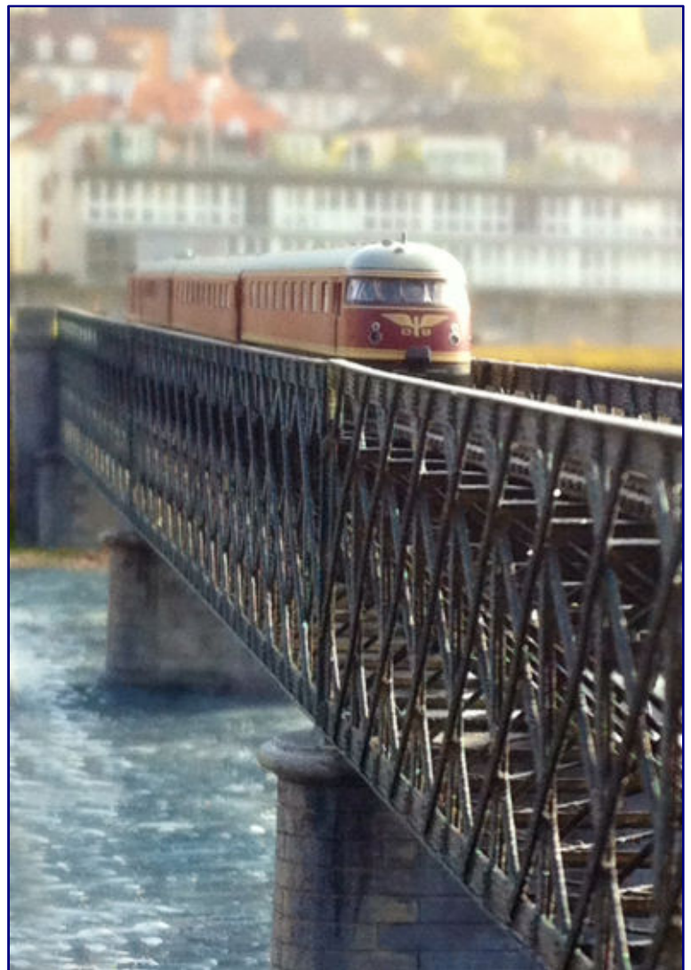
Die frühere Rheinbrücke von Basel wird vom VT 08 5 der DB überquert. (Folgebild auf der nächsten Seite). Fotos: Martin Zimmermann
