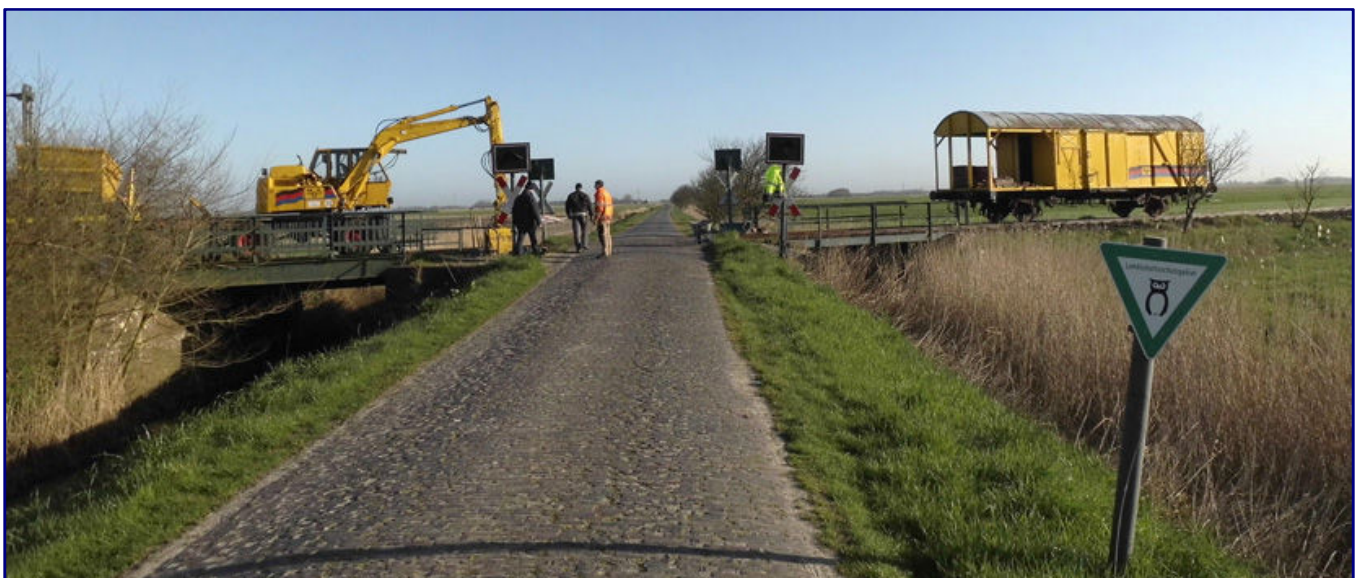
Heute ist der Waggon nach einem Umbau zum gelben Bauzugwagen, auf dessen Längsseite die ostfriesische Flagge als Zierband aufgebracht ist, wieder unter seiner alten Betriebsnummer MKO-022 unterwegs. Auf dieser Aufnahme ist er 2014 bei einer Bahnübergangsreparatur in Westerende zu sehen. Foto: MKO e.V.
