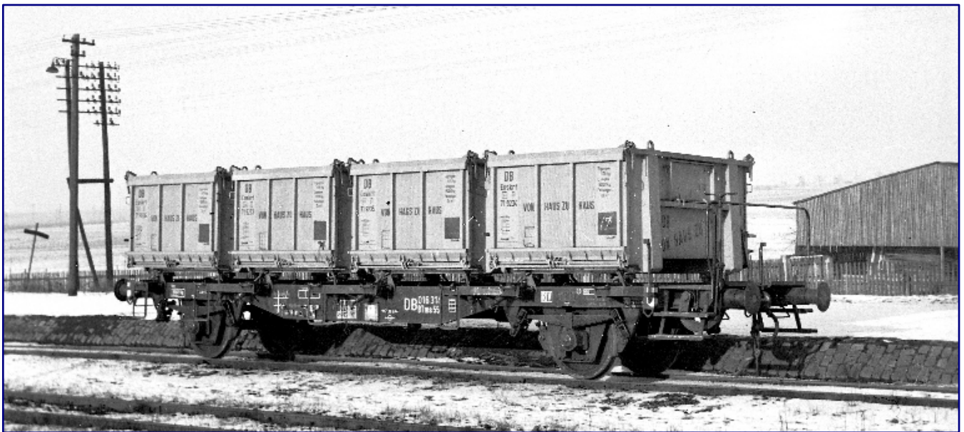
Der ab 1955 in Serie gebaute Behältertragwagen BTms 55, hier das Exemplar mit der Betriebsnummer 016 314, markiert den Übergang zum vierständigen Wagen. Im Januar 1958 wurde er mit Eoskrt-21-Behältern im Bild festgehalten, die, mit Stahlaufsatzwänden erhöht, die korrekte Vorlage für Märklins jüngstes Modell gewesen wären. Foto: Reinhard Todt, Eisenbahnstiftung
