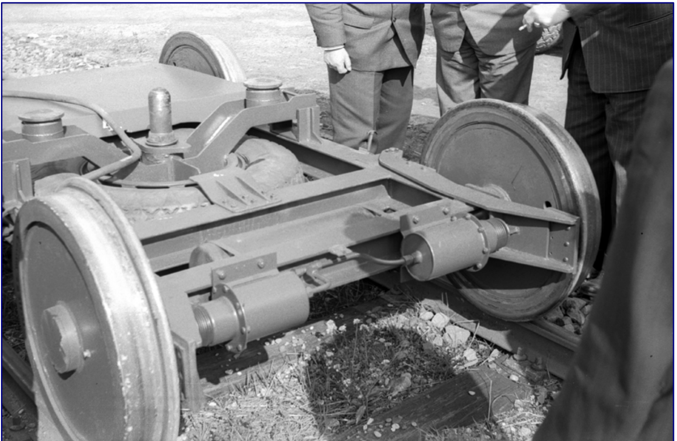
Hier wird, laut Aufzeichnungen im Mai 1954 in Dürstadt, das auf einem Krauss-Maffei-Bus basierende Exemplar mit dem Besatzungskennzeichen AB 06-5410 aufgeleitet (Bild oben). Der Blick auf den Spurwagen zeigt auch die Bremszylinder samt Zuleitungen (Bild unten). Fotos: A. Dormann, Slg. W. Löckel (Eisenbahnstiftung)
