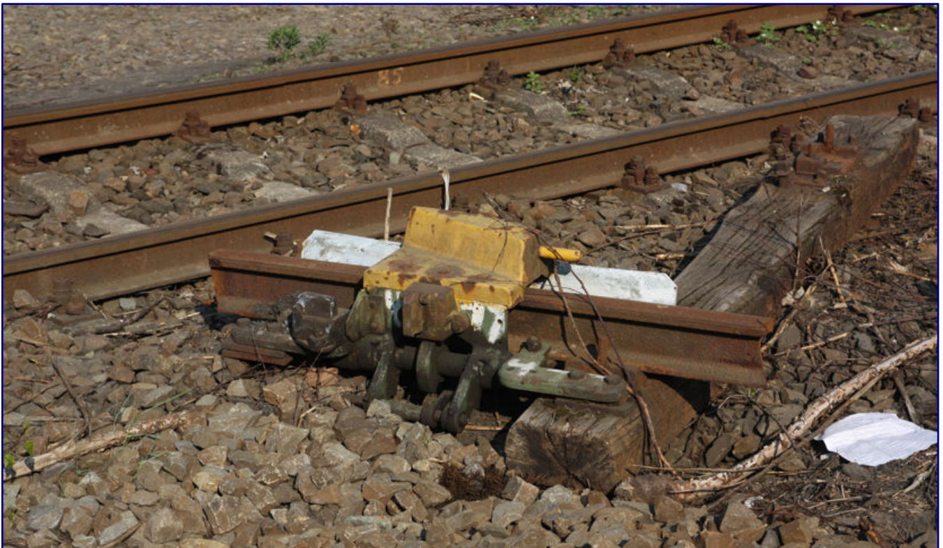
Fast zwei Jahre lang lagen viele Teile der Signaltechnik im damals noch nicht umgebauten Opladener Bahnhofsbereich rostend herum (Bild oben). Der Bahnhof Leverkusen-Schlebusch hatte vormals eine Reihe von Abstellgleisen. Nach dem Rückbau lag hier über Jahre das Reststück einer Gleissperre weiter im Schotterbett (Bild unten).
