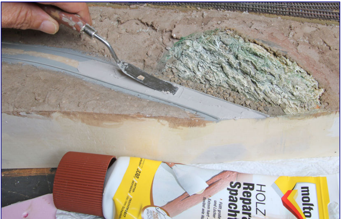
Mit einem Spachtelmesser wird die Masse sorgsam verteilt.
