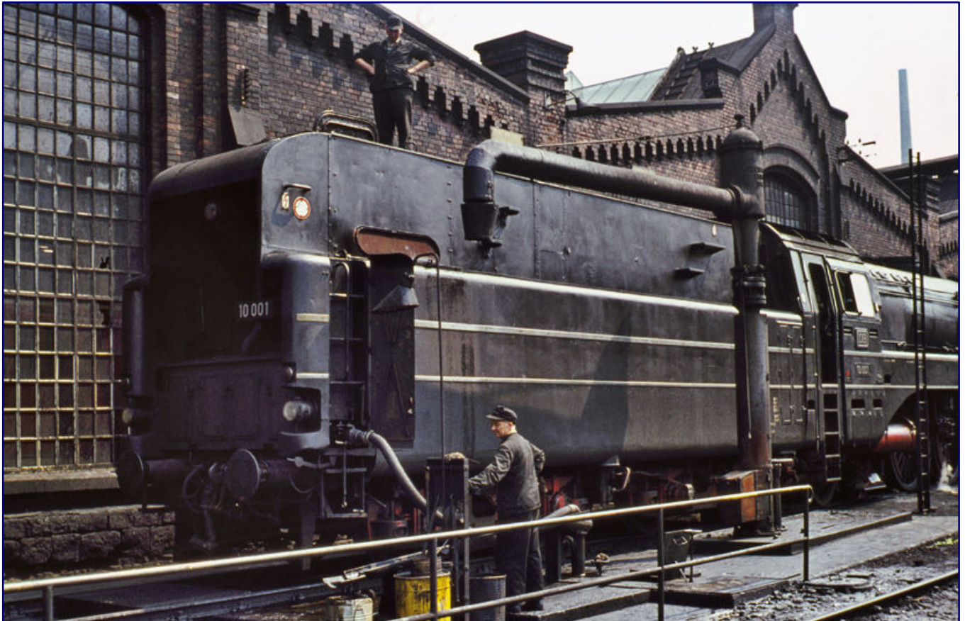
Komplett neu konstruiert war der Tender 2'2' T 40 der Baureihe 10, dessen Aufstiegsleitern unter der Verkleidung verdeckt lagen. Zu öffnen waren deren Klappen auch für das Bunkern von schwerem Heizöl mittels Steigrohr, wie hier bei 10 001 am 17. Juni 1966 in ihrem Heimat-Bw Kassel zu sehen ist. Foto: Kurt Reimelt, Bildarchiv Eisenbahnstiftung
