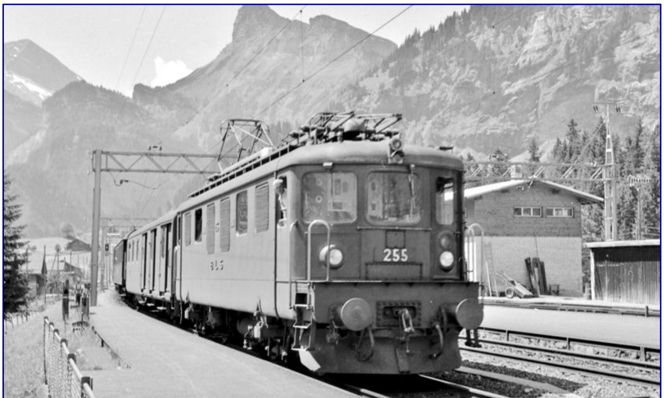
Die Ae 4/4 der BLS war eine laufachslose Ellok, an der sich die DB orientieren konnte. 1944/45 wurden zunächst zwei Exemplare beschafft, bis 1954 folgten sechs weitere. Hier fährt die Ae 4/4 255 im Juni 1956 mit Schnellzug 133 in Kandersteg ein. Foto: Kurt Eckert, Sammlung Eisenbahnstiftung
