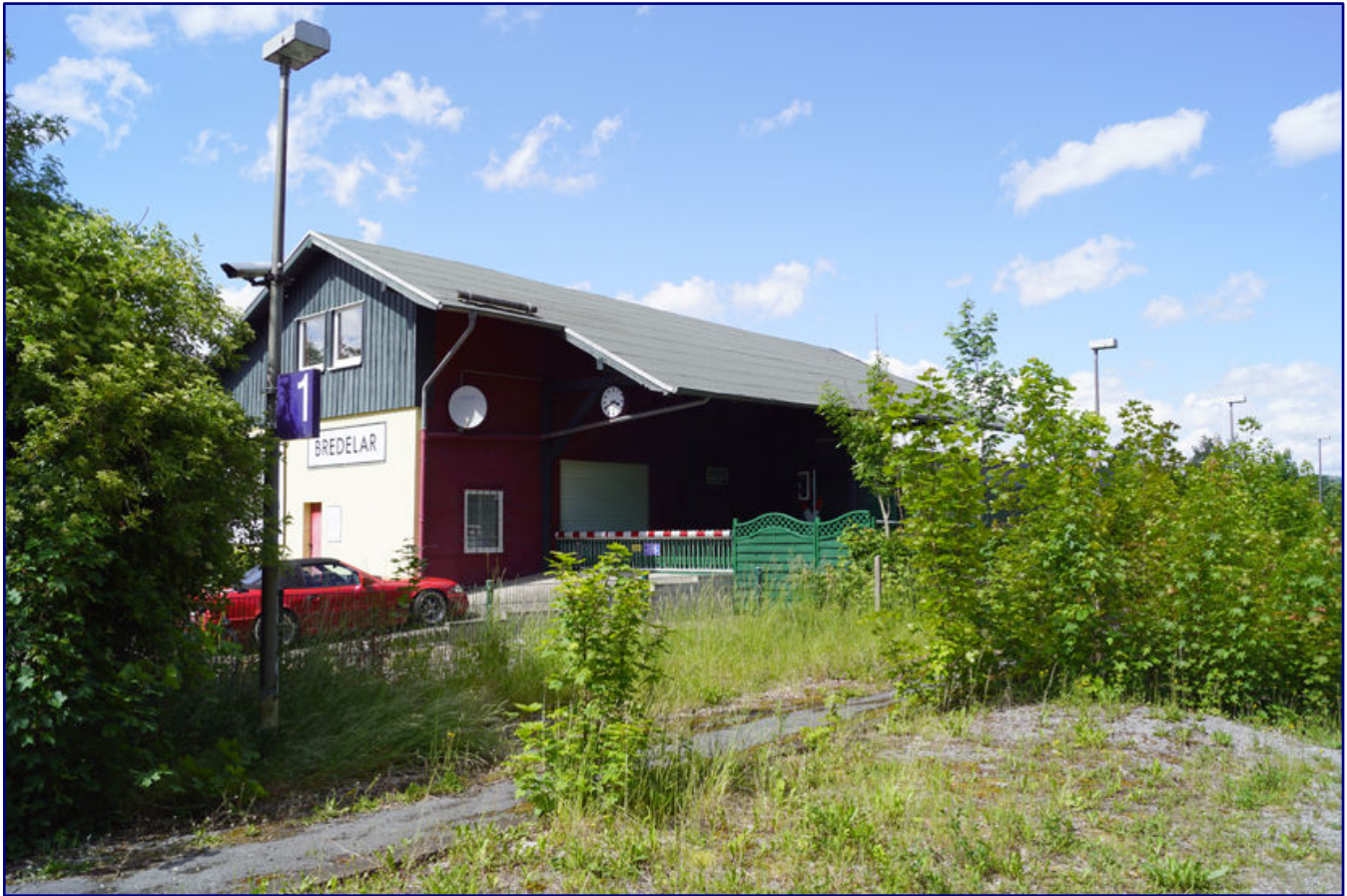
Am Bahnhof Bredele ist der eingleisige Rückbau zwischen Brilon und Warburg besonders gut nachzuvollziehen: Heute nur noch ein Haltepunkt mit einem Gleis, steht das im Juni 2020 längst privat genutzte Empfangsgebäude auffällig weit weg davon. Fotos: Märklin
