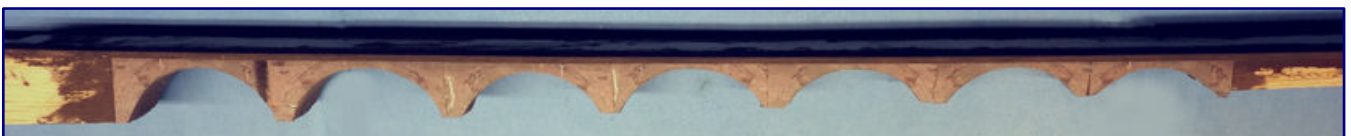
In Pfeilermitte sind die Stoßkanten nicht exakt auszurichten: sie werden im weiteren Verlauf noch mit einer Ziegelmauerwerksstütze verdeckt.
