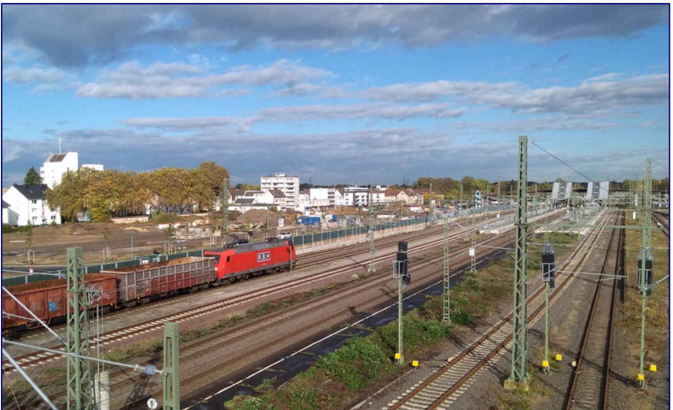
Die neue Güterzugstrecke (Bild oben) ist gerade ein paar Tage in Betrieb. Das Bild aus dem Jahr 2019 zeigt den Zustand vor dem Bebauen mit Wohnkomplexen (Bild unten).
