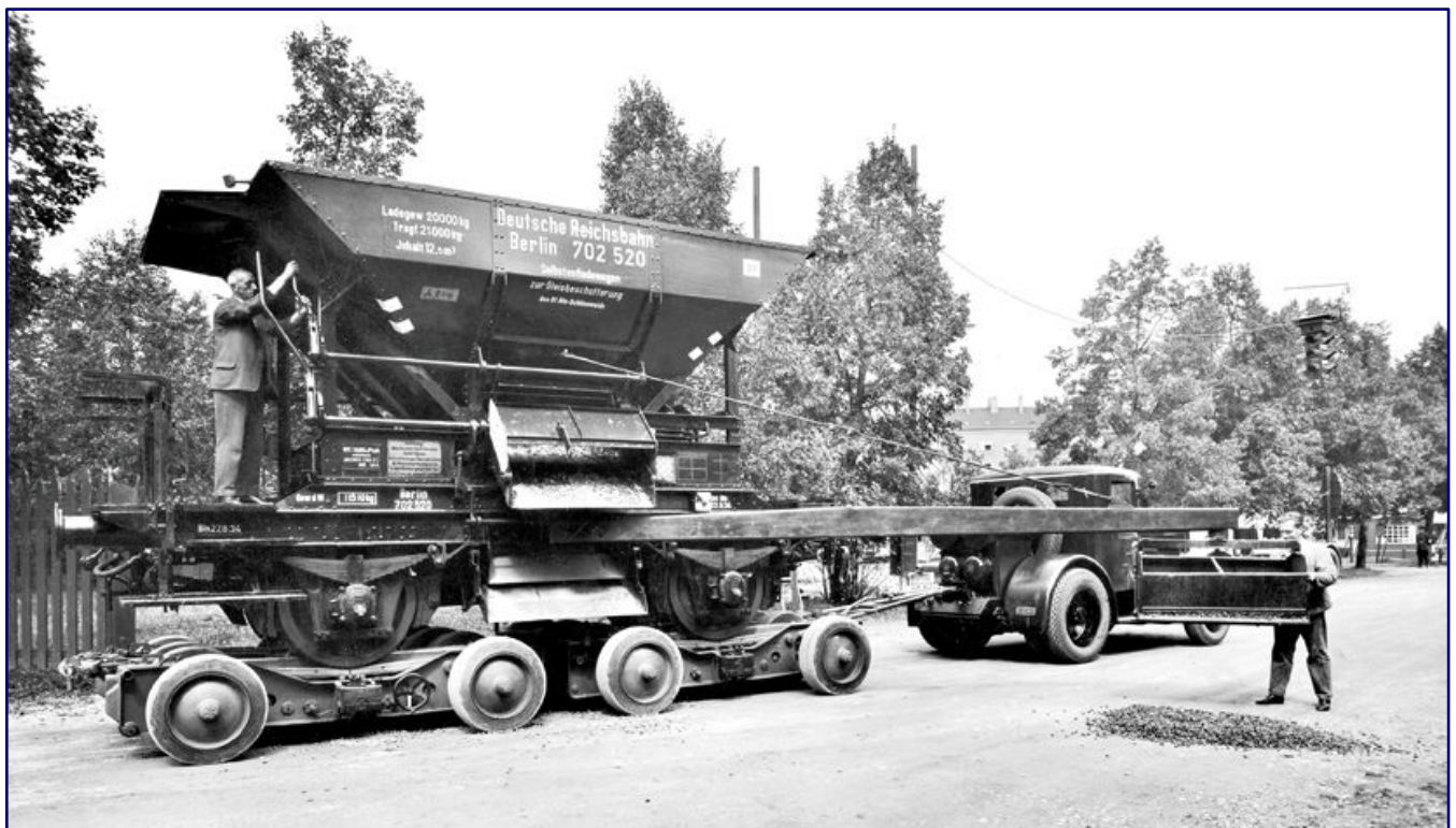
Im Rahmen einer 1934 in München abgehaltenen Straßenbauausstellung führt der 20 t-Schotterwagen auf einem Straßenroller seine grundsätzliche Tauglichkeit im Straßenbau beim Verfüllen von Schlaglöchern vor. Bei dem von Talbot gebauten Selbstentladewagen zur Gleisbeschotterung „Berlin 702 520“ handelt es sich um einen echten Klassiker der Bahndienstwagen. Foto: RVM, Eisenbahnstiftung
